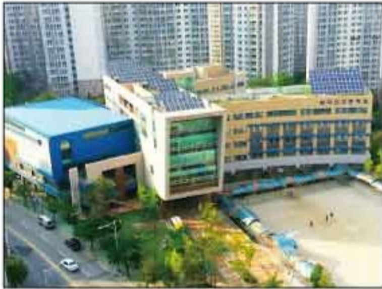
07 ▶ 현장명 : 삼각산 고등학교 ▶ 적 용 : 내벽 패널 공사 150T
