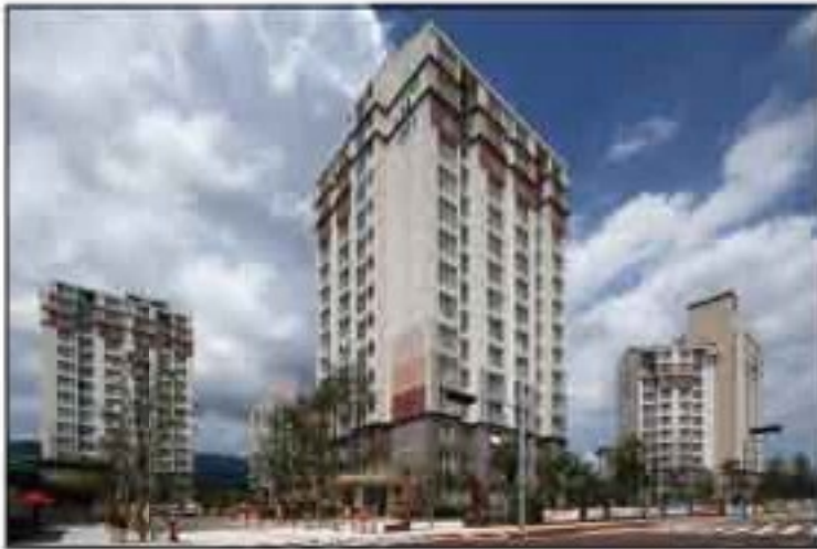
09 ▶ 현장명 : LH공사 계동 중방아파트 ▶ 적용 : 외벽 패널 공사 100T
