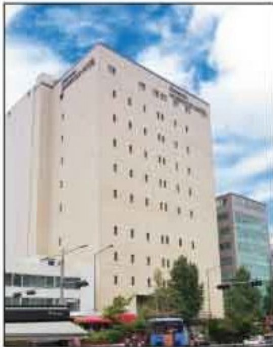
08 ▶ 현장명 : 서교동 테라타워 호텔 ▶ 적 용 : 내부 컨택이 블록 200F
