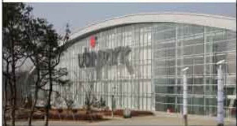
08 ▶ 현장명 : 파주 유티파크 ▶ 적 용 : 외벽 패널 공사 120T
