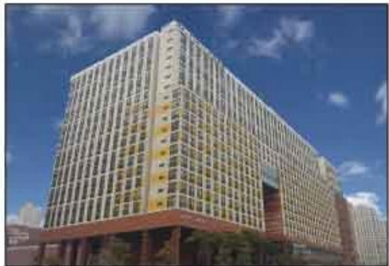
09 ▶ 현장명 : 광포 1, FORT PARK ▶ 적 용 : PD/AD, 화장실, 세대내버 / 100F, 200F
